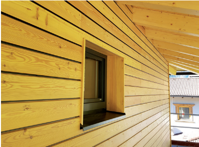
Holzhaus Obergeschoss außen Holzfassade
