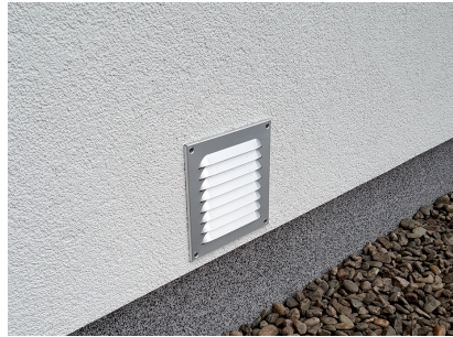
Sockeldämmung mit Putz
