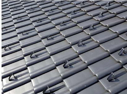
Dachdecker Dachdeckung mit Tonziegel
