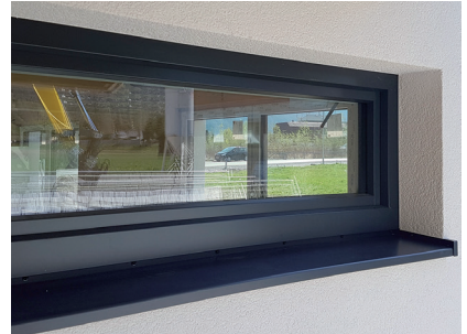
Stranggepresste Fensterbänke außen – Aluminium beschichtet
