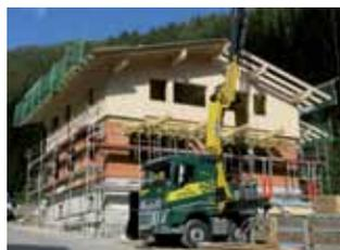
**SCHNELLER GEHT'S NICHT:** Die Vorfertigung großer Elemente und der extrastarke 4-Achsen-LKW mit 30-Meter-Kran machen extrem kurze Montagezeiten möglich.
